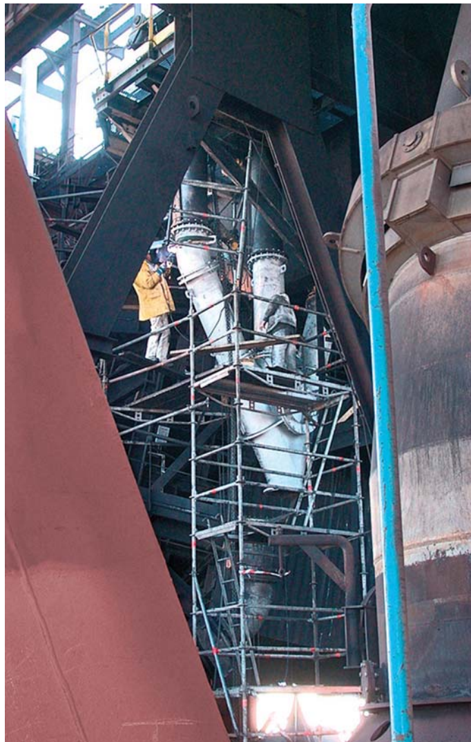
Montage d'une conduite de compensation de pression sur le haut fourneau ; la structure autoporteuse en acier rechargé KALMETALL-W 100 30 + 6 présente un diamètre de 450 mm
