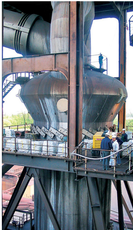
Revêtement d'un cyclone de dépoussiérage en composite dur KALCRET-BTS à projeter ; la mise en place de ce type de revêtement est très rapide (plus de 5m 2 /h)
