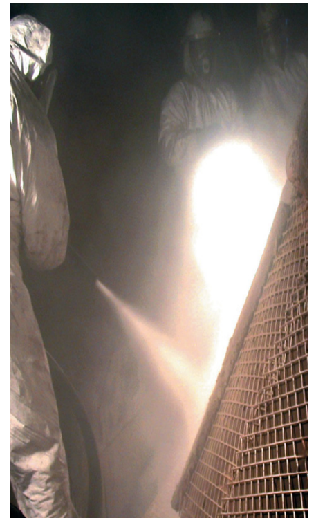
Revêtement d'un cyclone de dépoussiérage en composite dur KALCRET-BTS à projeter ; la mise en place de ce type de revêtement est très rapide (plus de 5m 2 /h)
