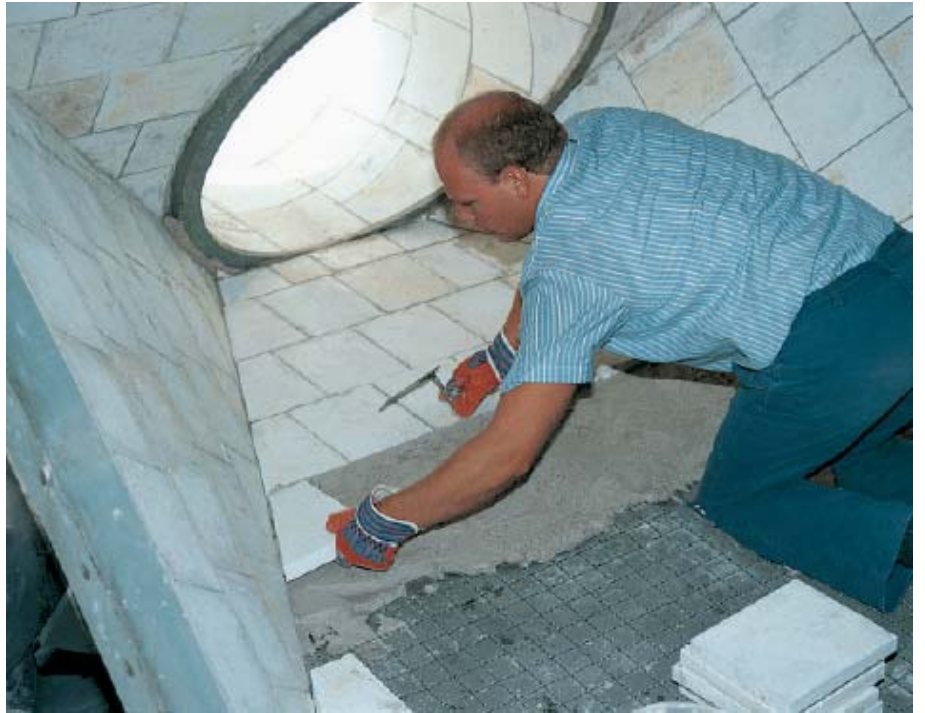
Sammeltrichter in der Sinterentstaubung bei 400 °C: wirkungsvoll geschützt mit Zirkonkorund KALCOR
