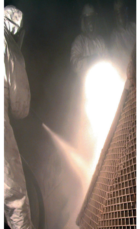
Kurze Auskleidungszeiten eines Entstaubungszyklons mit spritzbarem Hartstoffkompond KALCRET-BTS; die Aufbringleistung beträgt mehr als 5 m 2 /h
