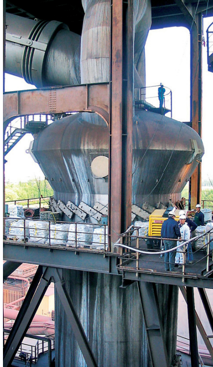
Kurze Auskleidungszeiten eines Entstaubungszyklons mit spritzbarem Hartstoffkompond KALCRET-BTS; die Aufbringleistung beträgt mehr als 5 m 2 /h
