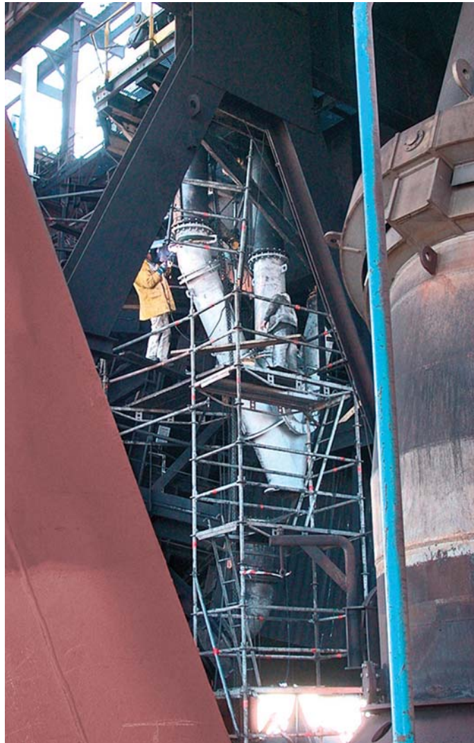
Montage einer Druckausgleichsleitung am Hochofen – die selbsttragende Konstruktion als Hartauftragschweißung KALMETALL-W 100 30 + 6 hat einen Durchmesser von 450 mm
