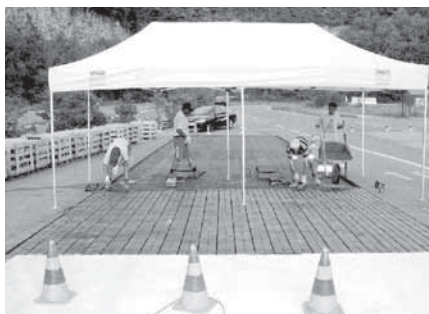
Montage der Teststrecke mit Schmelzbasalt ABRESIST
