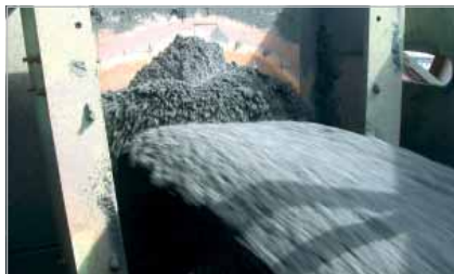
KERAFLEX Auskleidung im Bunker eines Umschlagbetriebes
