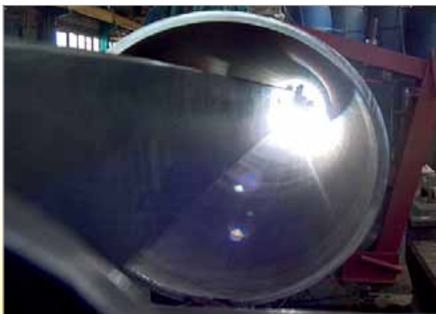
Rechargement par soudage d'une tuyauterie : amélioration de la durée de vie et réduction du poids
