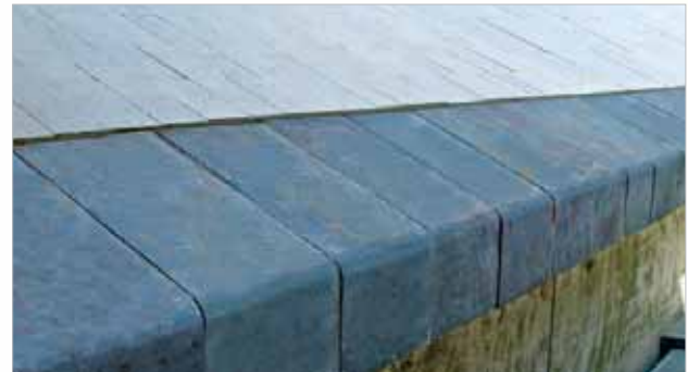
Revêtement en KALMETALL-C sur une rampe à coke en liaison avec le matériau céramique de carbure de silicium KALSICA et la céramique dure KALCERAM-K
