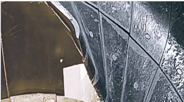
Spire de descenseur de houillère revêtue en KALMETALL-C
