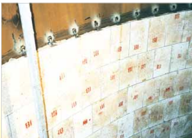
Protection contre l'usure à température élevée : cyclones de dépoussiérage de haut fourneau
