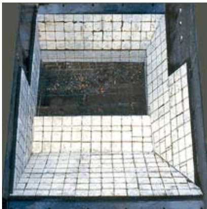
Bunkerauskleidung mit KERAFLEX-KRM Elementen in einem Stahlwerk
