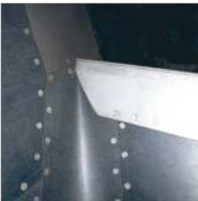
Les cornières KALINOX protègent la voûte de la trémie revêtue en KALEN.
